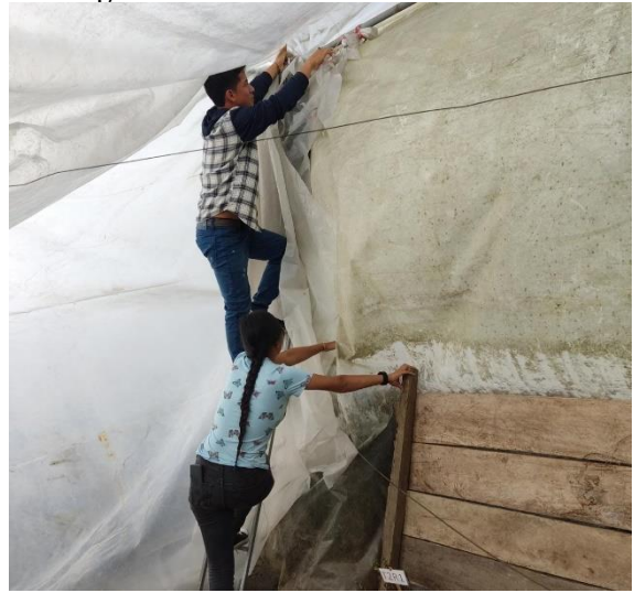
Fotografía 2. Armado de cubierta
