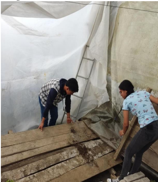
Fotografía 3. Colocación de tablas
