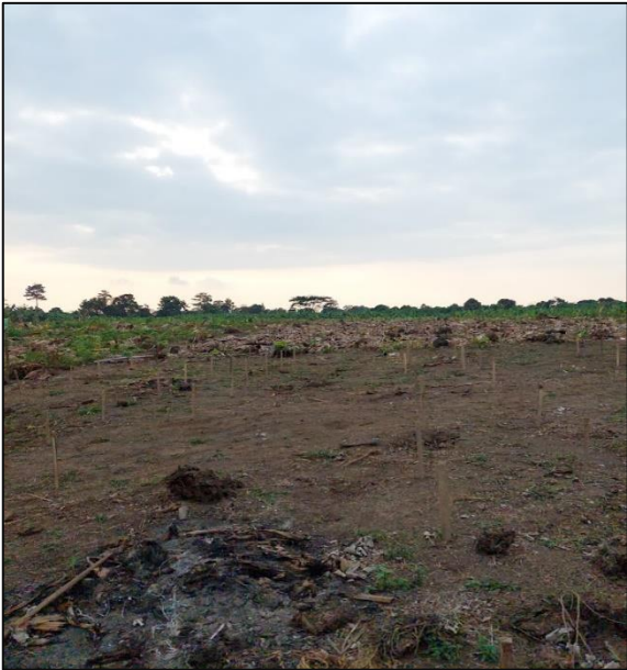
Fotografía 1. Limpieza y preparación del terreno
