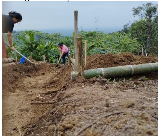
Fotografía 2. Limpieza del terreno
