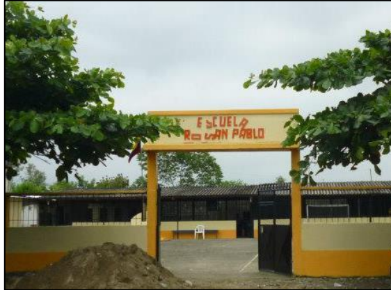
Figura 46. Fachada frontal de la E.B Río San Pablo
