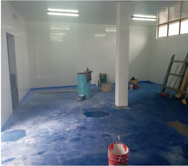
Fotografía 13. Remodelación pisos área de Producción
