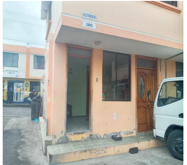
Fotografía 6. Baños y Vestidores
