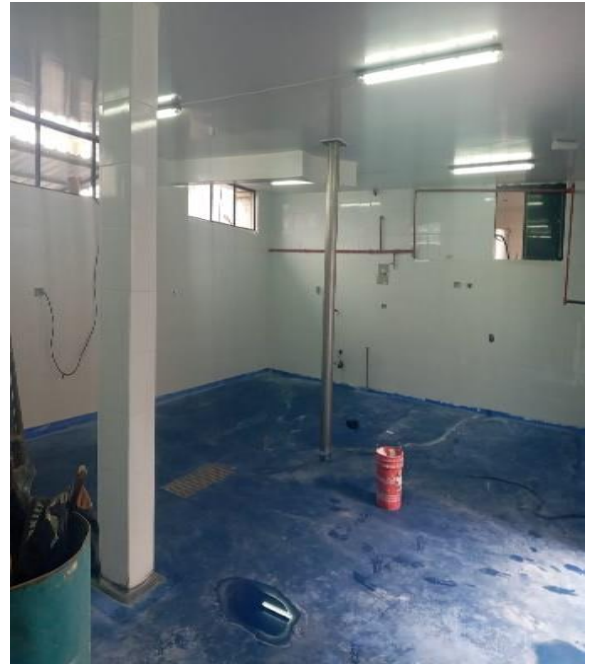
Fotografía 12. Remodelación planta de producción
