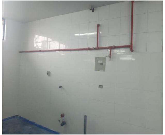
Fotografía 14. Remodelación paredes área de producción.
