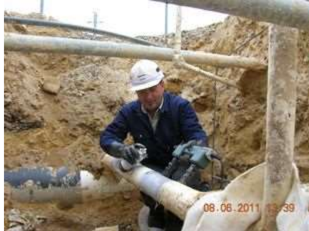
Figura 2. Inspección por Partículas magnéticas.
