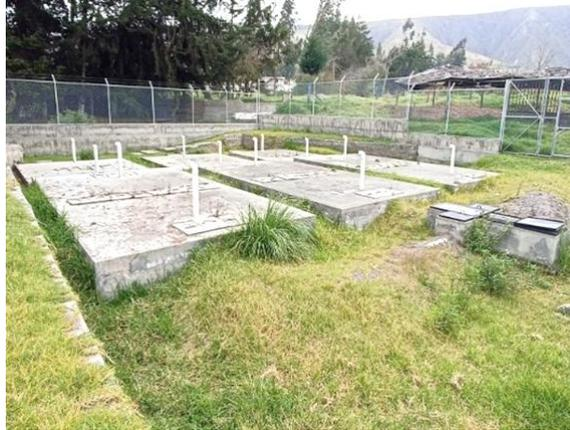
Se realizaron inspecciones etapa por etapa para verificar que el estado físico de cada una de ellas, en donde a primera vista de la parte exterior no es evidente el mal estado del sistema. En cuanto al revisar el interior de cada etapa (**Fig. 8.**) se aprecia muy claramente que hay excedentes de sedimentos, raíces que invaden casi en su totalidad el interior del sistema, lo cual nos muestra la falta de mantenimiento.
