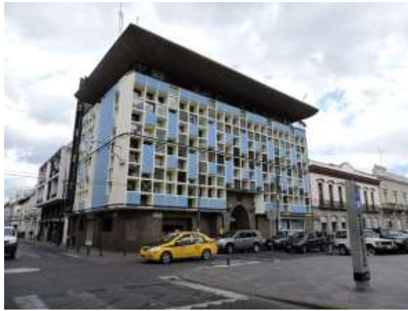
Figura 4. Empresa Eléctrica Riobamba S.A.
