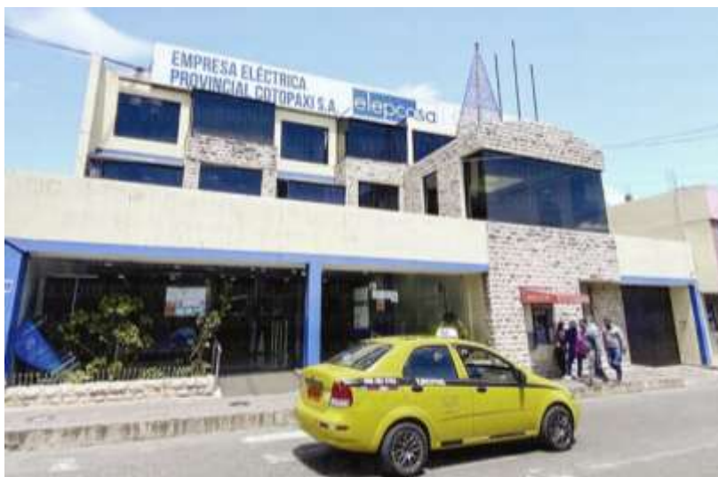
Figura 3. Empresa Eléctrica Provincial Cotopaxi S.A.
