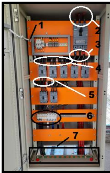
Figura 40. Tablero de distribución terminado en su montaje de elementos y cableado.
