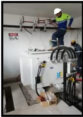
Figura 36. Armado de puntas terminales y equipos de medición de media tensión.
