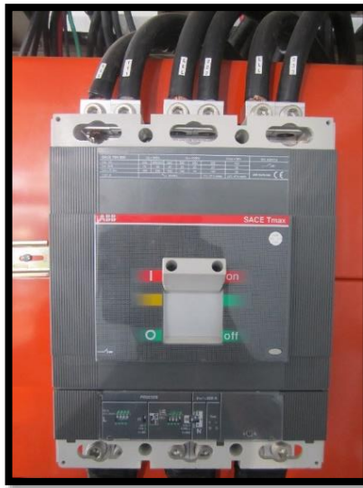
Figura 13. Interruptor-Disyuntor Caja Moldeada Trifásico.
