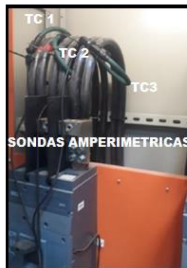
Figura 16. Colocación de las sondas amperimétricas en la acometida principal.
