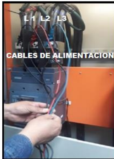
Figura 17. Colocación de cables tipo lagarto en las líneas activas de la acometida y el neutro.
