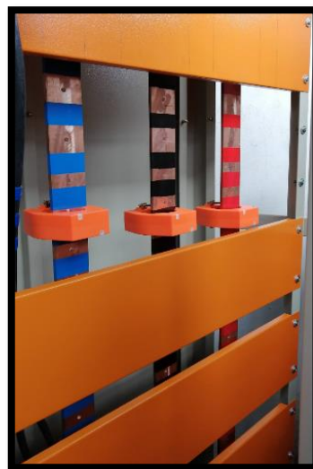
Figura 38. Montaje de los transformadores de corriente TC en las barras de distribución de cobre 800 A.
