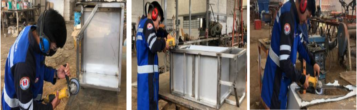
Figura III.4. Pulido de estructura
