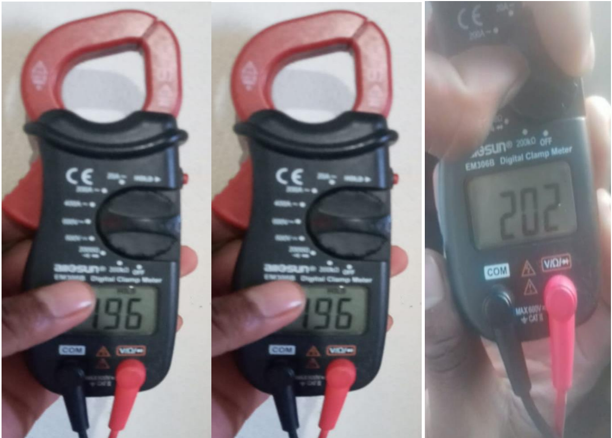
Imagen 2. Medidas de tensión en tablero eléctrico.
