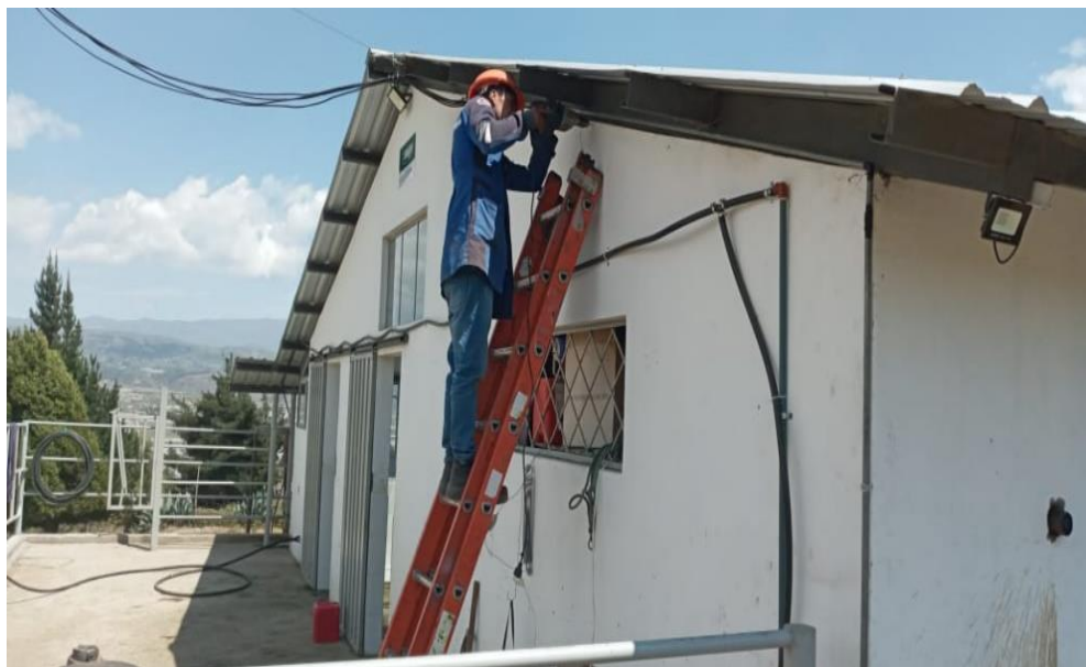
Imagen 21. Aseguramiento de conductor desnudo puesta tierra.
