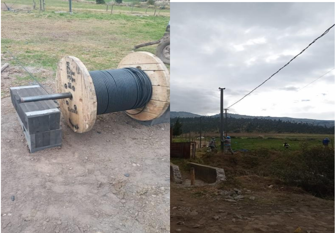
Imagen 6. Conductor calibre N° 2 AWG.
