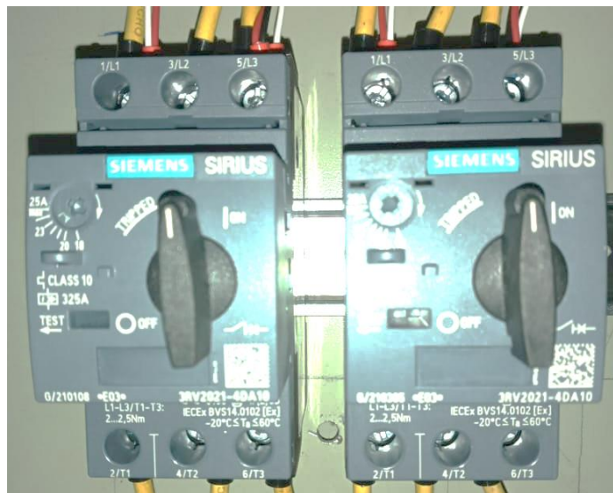
Figura 6. Guardamotor (Siemens).
