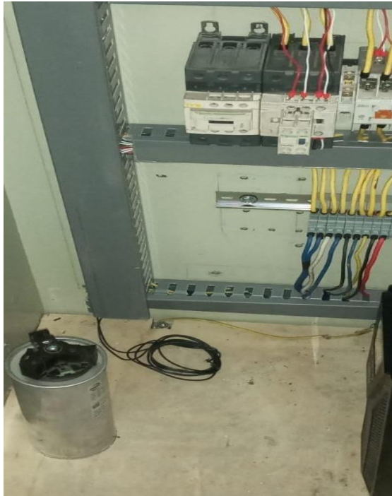
Imagen 14. Implementación del banco de capacitor.
