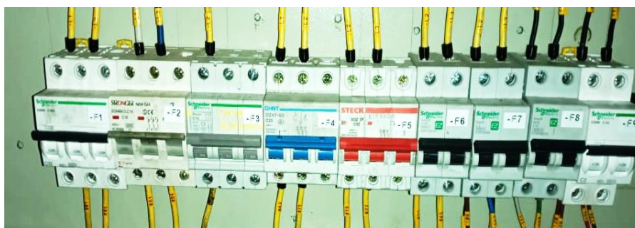
Figura 5. Interruptor termomagnético.
