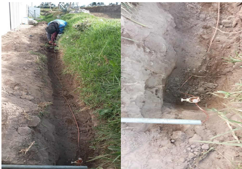
Imagen 20. Implementación de puesta tierra.
