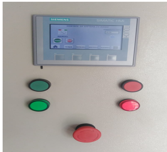
Anexo C.2. Amado de elementos de caja térmica, (pulsadores, luces piloto, HMI)
