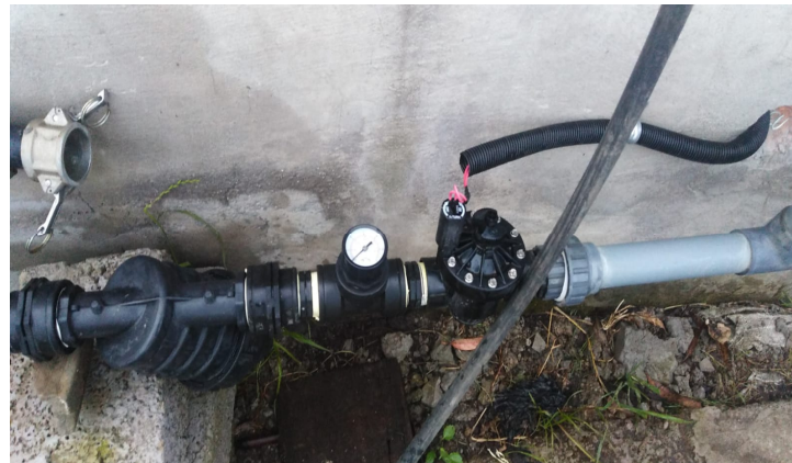
Anexo L.2. Centrado de manómetro para visualización de presión (1 Bar).
