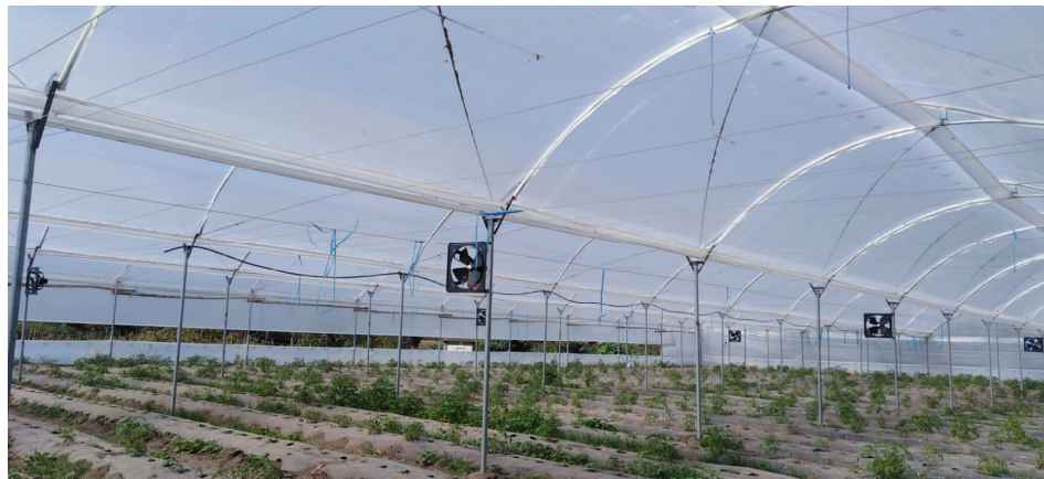
Anexo F.2. Colocación de extractores en los puentes tubulares de 2'' de acero galvanizado
