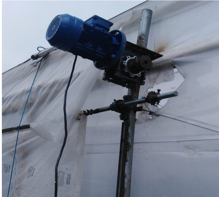
Anexo H.1. Colocación de: eje roscado de 1", tuercas, motor reductor y piñones de transmisión
