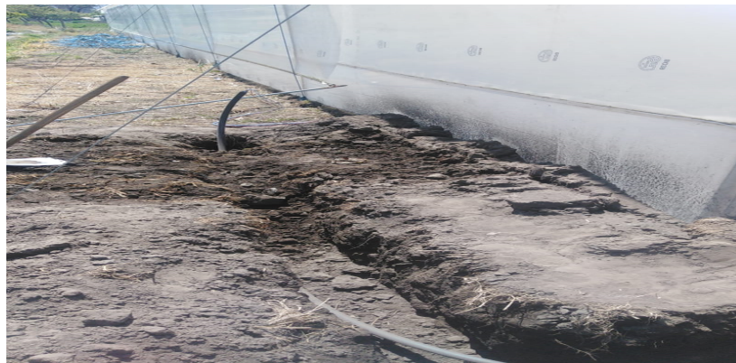
Anexo N.4. Tapada de acometidas y tubería con conductores
