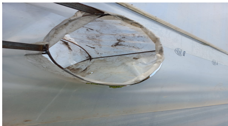
Anexo I.2. Enrollamiento y grapado de ducto con plástico de invernadero.
