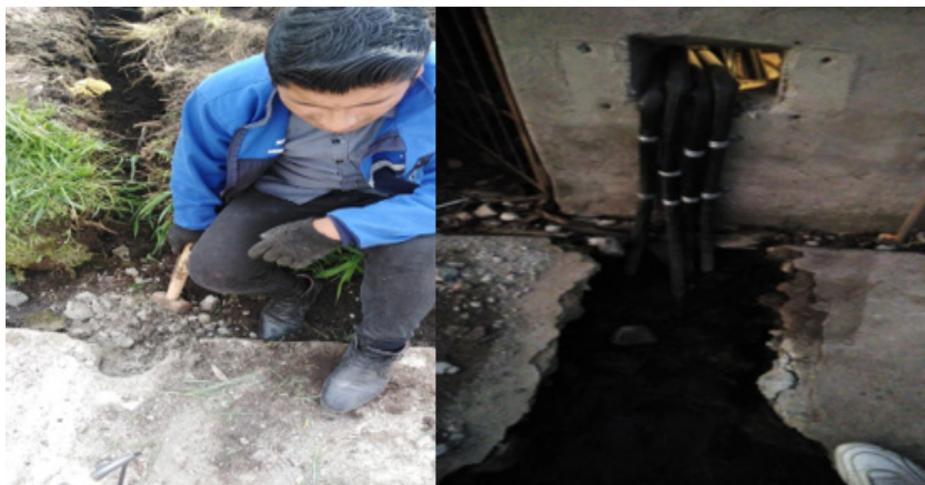
Anexo N.2. excavación de acometidas, para cableado de motorreductores, sensores de temperatura y humedad, finales de carrera, electrovalvas de distribución.
