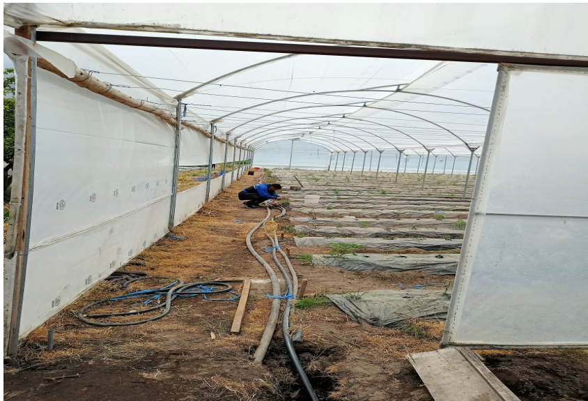
Anexo N.3. Colocación de manguera con cableado para el sistema de control y Temperatura.
