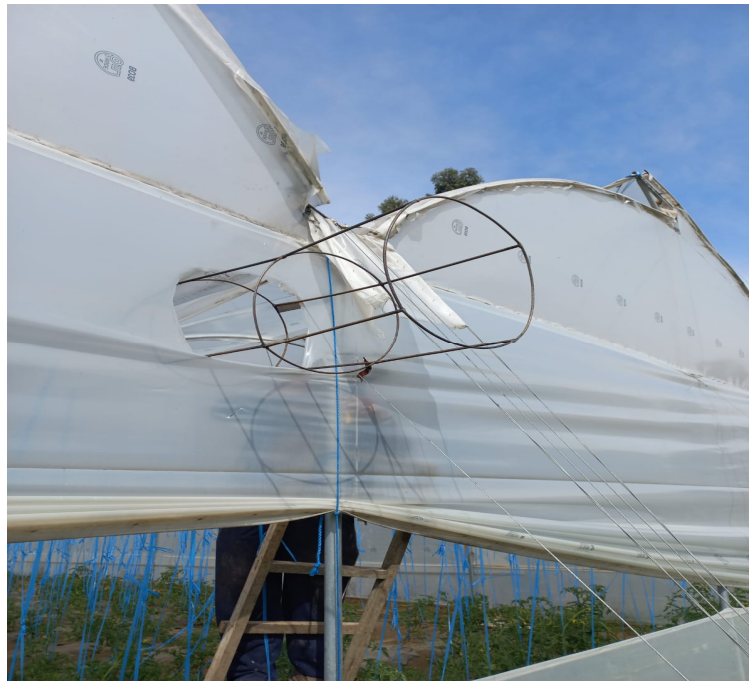
Anexo I.1. Armado y centrado de ducto circular de flujo de aire.
