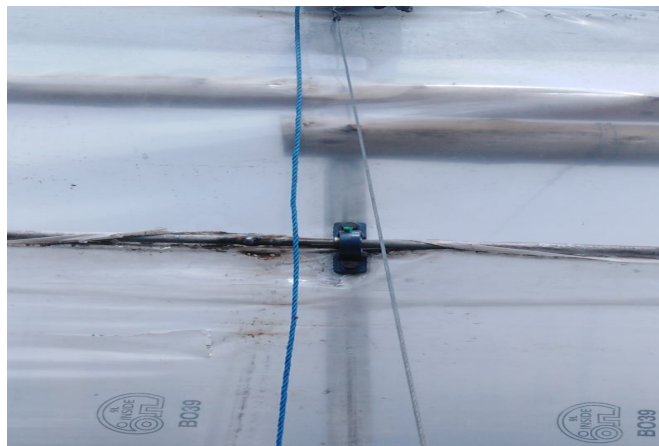
Anexo H.2. Centrado de chumaceras de 3/4 con eje galvanizado de cortinas
