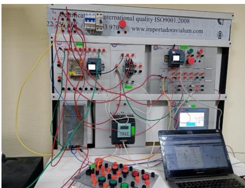
Figura 5.4. Comunicación del sistema por medio de cable UTP.
