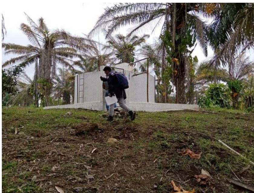
Figura 3.4. Tanque de recepción de 40m^3 , Recinto Santa Marianita.
