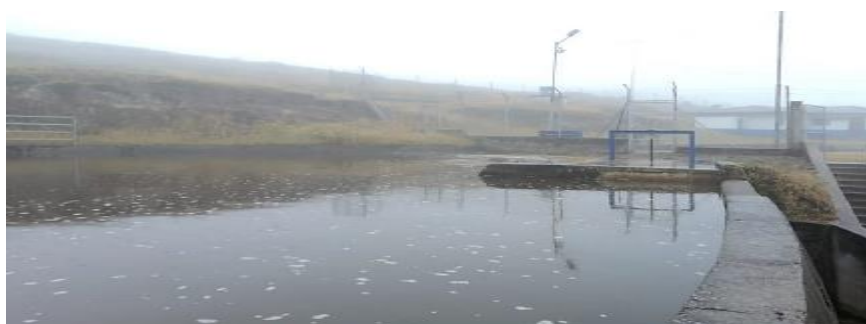
Figura 3.1 Tanque de captación perteneciente a la central hidroeléctrica ILLUCHI II.
