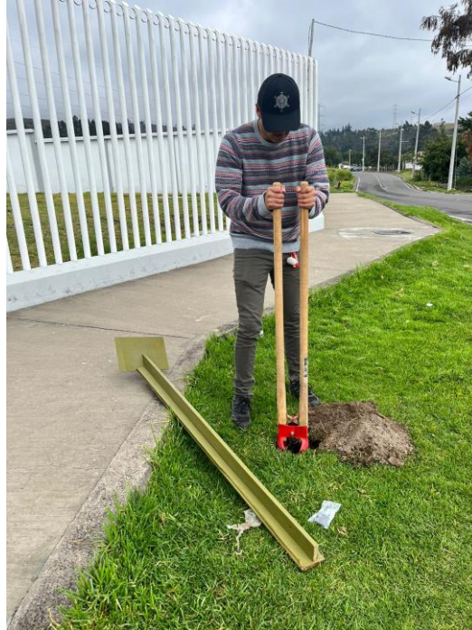
Figura 45 Construcción de señalética Hito física
