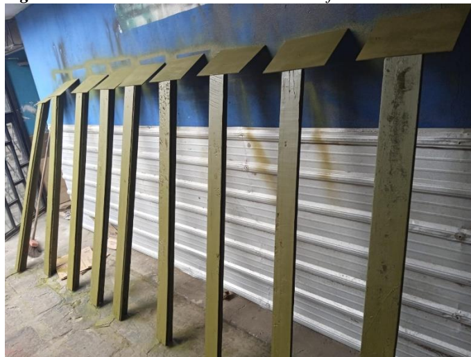
Nota: Construcción de señalética física “hito”
