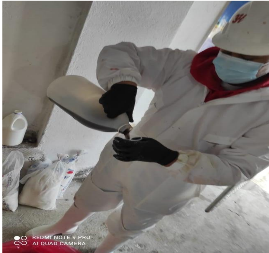
Figura 29: Colocación de Cloro o Cresol.
