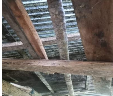
Fotografía 14. Techo de las instalaciones de trapiche.
