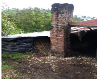
Fotografía 9. Ingreso a las instalaciones del trapiche.
