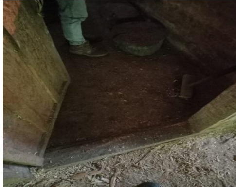
Ilustración 5. Pisos de trapiche de tierra.
