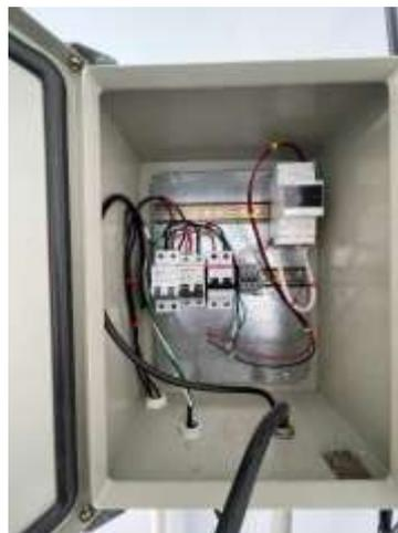
**Fotografía E.14:** Instalación del PV-Monitor.
