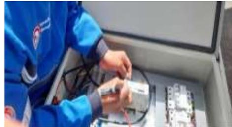
**Fotografía E.13:** Instalación de la fuente de 24V
