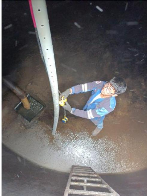
**ANEXO IX:** Instalación de flotadores eléctricos en tanque de agua.
