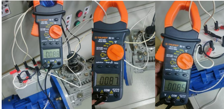
Figura 47 Medición de la corriente de línea con pinza amperimétrica externa al Sistema
