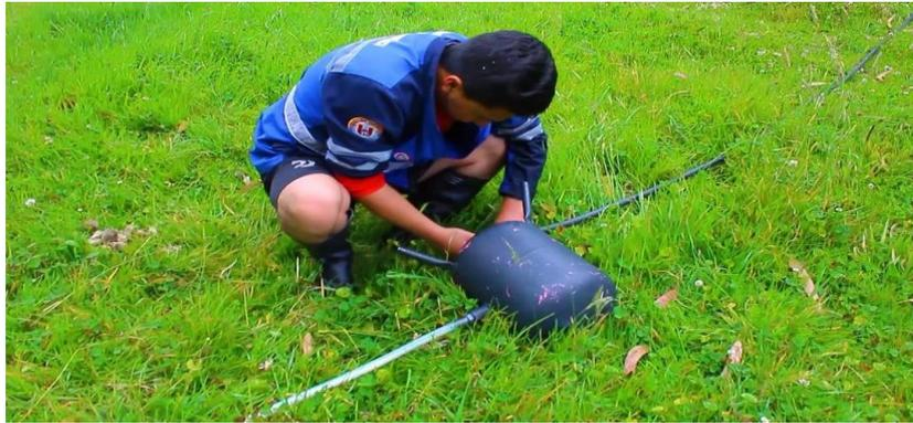
Anexo 7.10: Ensamble del sistema hidroneumático a la bomba
