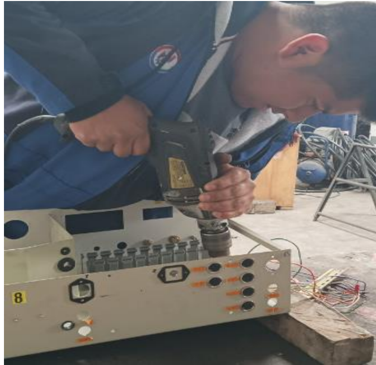
Figura XIX.48: Montaje de rieles din y canaletas en la caja 1
