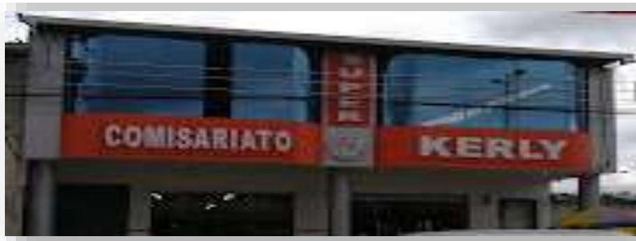
Ilustración 4: Fachada del comisariato Kerly
