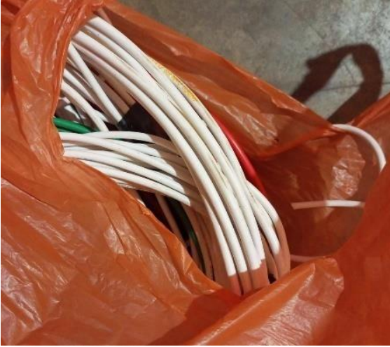
Imagen 6: Cables flexibles THW #12 AWG
