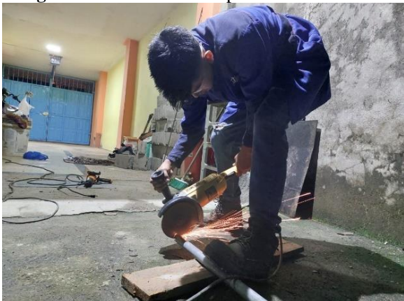
Imagen 1. Corte de material para la torre
