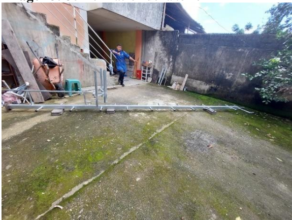
Imagen 3. Conformación de la torre
