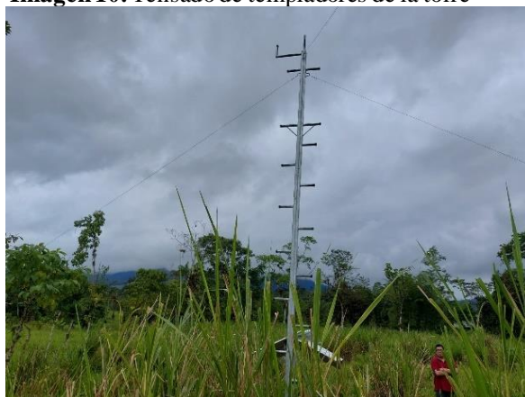
Imagen 10. Tensado de templadores de la torre
