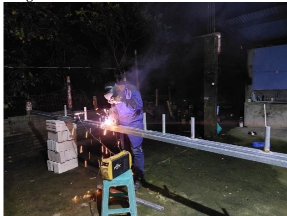
Imagen 2. Proceso de soldadura de la torre
