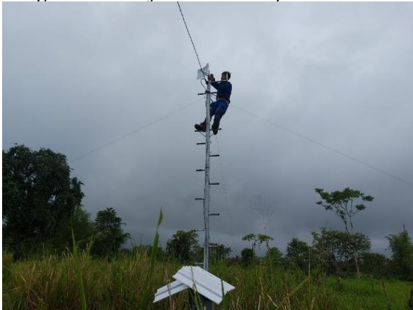
Imagen 17. Montaje de antena receptora
