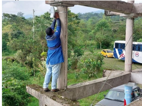
Imagen 18. Montaje de antena emisora
