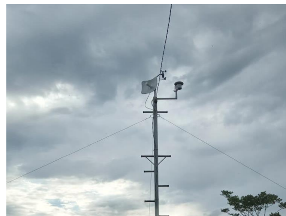
Imagen 24: Equipos ensamblados en la torre
