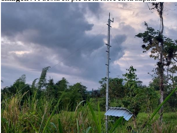
Imagen 9. Puesta en pie de la torre en la zapata
