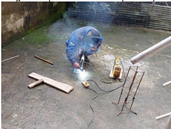
Imagen 4. Preparación de elementos para la zapata
