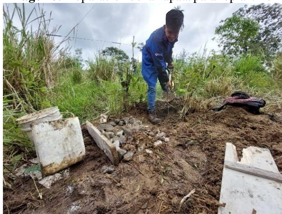
Imagen 8. Preparación de la zapata para replantillo
