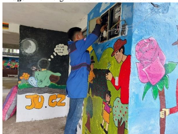
Imagen 14. Energizado de la línea eléctrica
