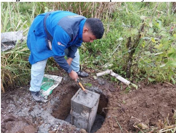
Imagen 7. Desencofrado de la zapata de sujeción
