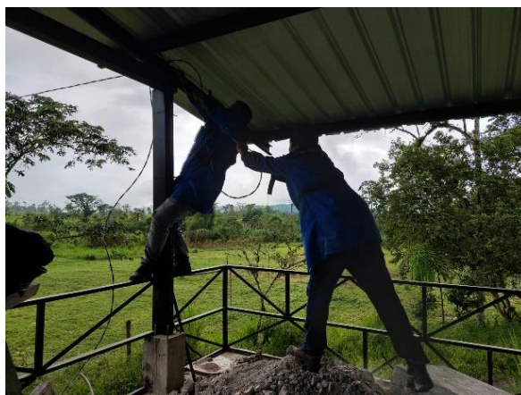
Imagen 12. Templado de cable desde el centro a la torre
