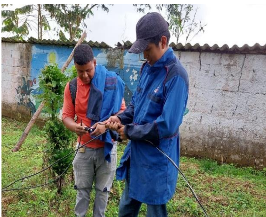
Imagen 11. Empalme de cables
