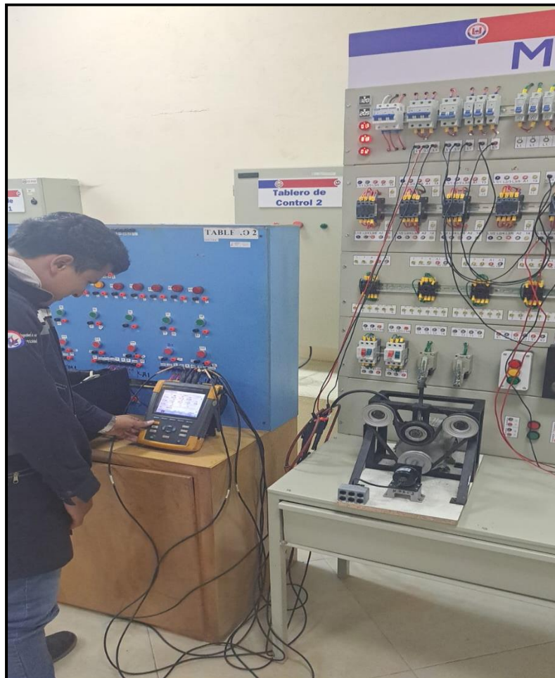
Anexo 2. Conexión con un variador de frecuencia en vacío y uso del analizador de redes.
