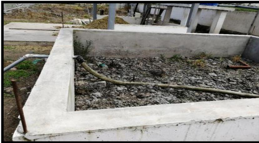
**Nota:** En la figura 18. se puede ver el tanque sedimentador del tratamiento de aguas del camal municipal, la cual se encarga de secar los lodos generados en el proceso.
