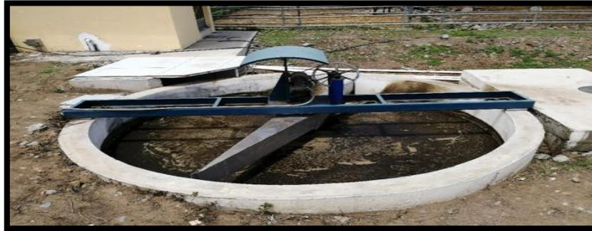
**Nota:** En la figura 13 se puede ver el sistema de flotación de aire disuelto del tratamiento de aguas del camal municipal, mismo que cuenta con un aspa que se encarga de remover los elementos que se forman en el mismo. **Fuente:** Elaboración Propia
