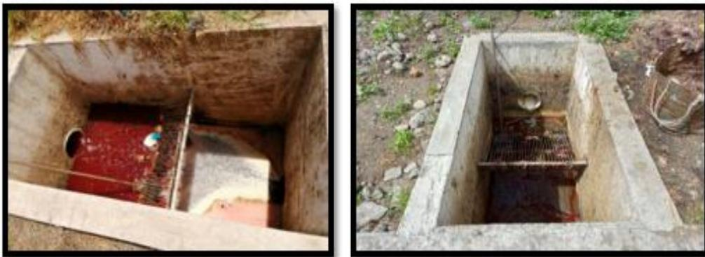
**Nota:** En la figura 8 se puede ver el sistema de criba o cajón repartidor con el que cuenta la planta de tratamiento de aguas del camal municipal **Fuente:** Elaboración Propia.
