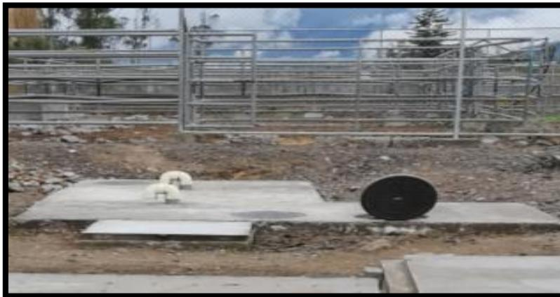
**Nota:** En la figura 15 se puede ver el tanque cisterna que se encarga de homogenizar el agua previo a su tratamiento final. **Fuente:** Elaboración Propia
