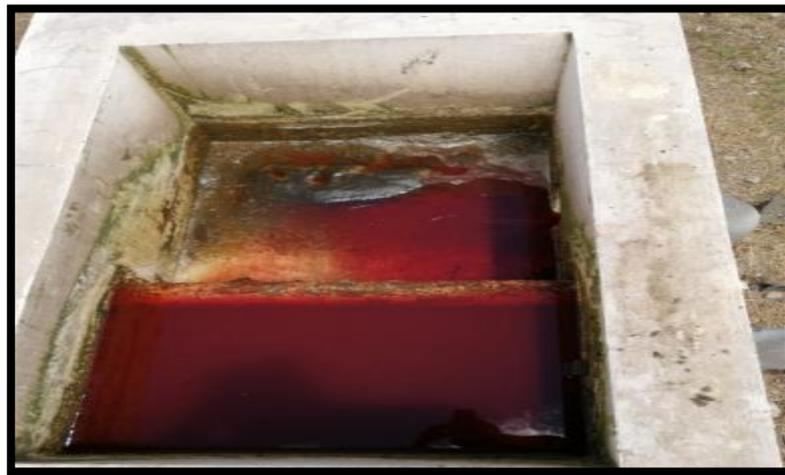
**Nota:** En la figura 11 se puede ver la cámara de entrada de la planta de tratamiento de aguas del camal municipal, donde el agua aún conserva un color rojo sangre característico del proceso de faenamiento. **Fuente:** Elaboración Propia
