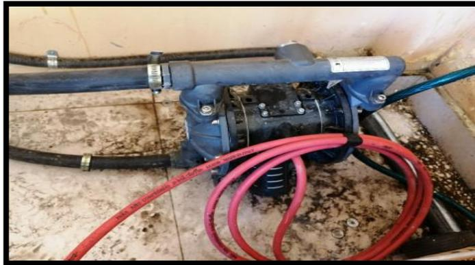
**Nota:** En la figura 16 se puede observar la bomba de lodos del tratamiento de aguas del camal municipal, la cual se encarga de movilizar los lodos generados en el proceso sedimentador. **Fuente:** Elaboración Propia
