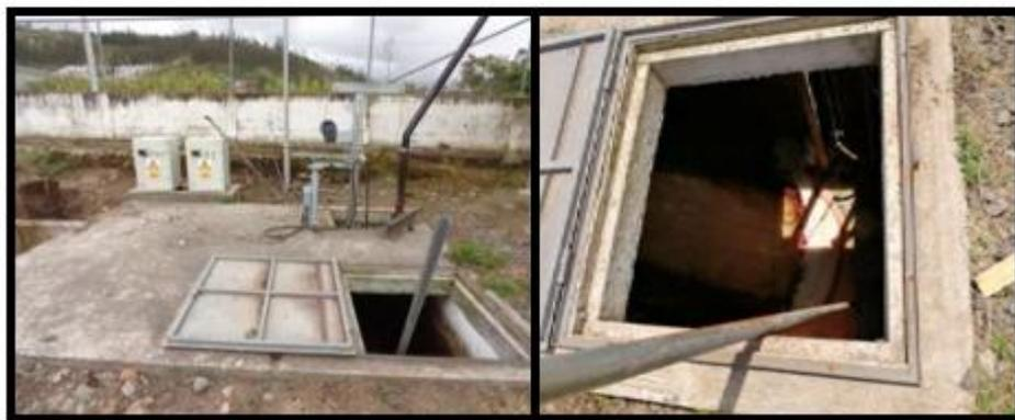
**Nota:** En la figura 9 se puede ver el tanque ruminal homogeneizador con el que cuenta la planta de tratamiento de aguas del camal municipal, siendo una infraestructura de hormigón. **Fuente:** Elaboración Propia
