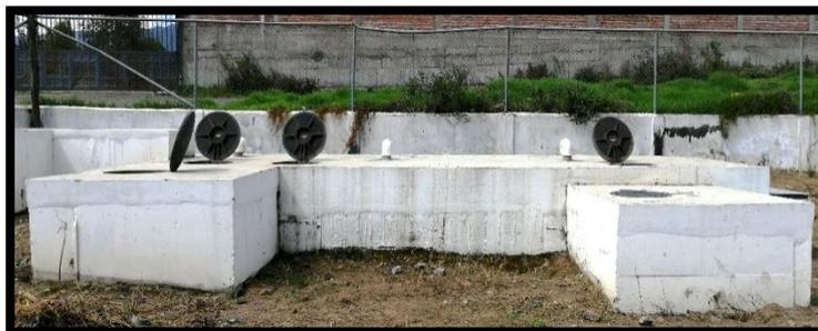
**Nota:** En la figura 12 se puede ver el conjunto de elementos que conforman el tanque sedimentador del tratamiento de aguas del camal municipal, mismo que está conformado por 4 tanques conectados entre sí. **Fuente:** Elaboración Propia
