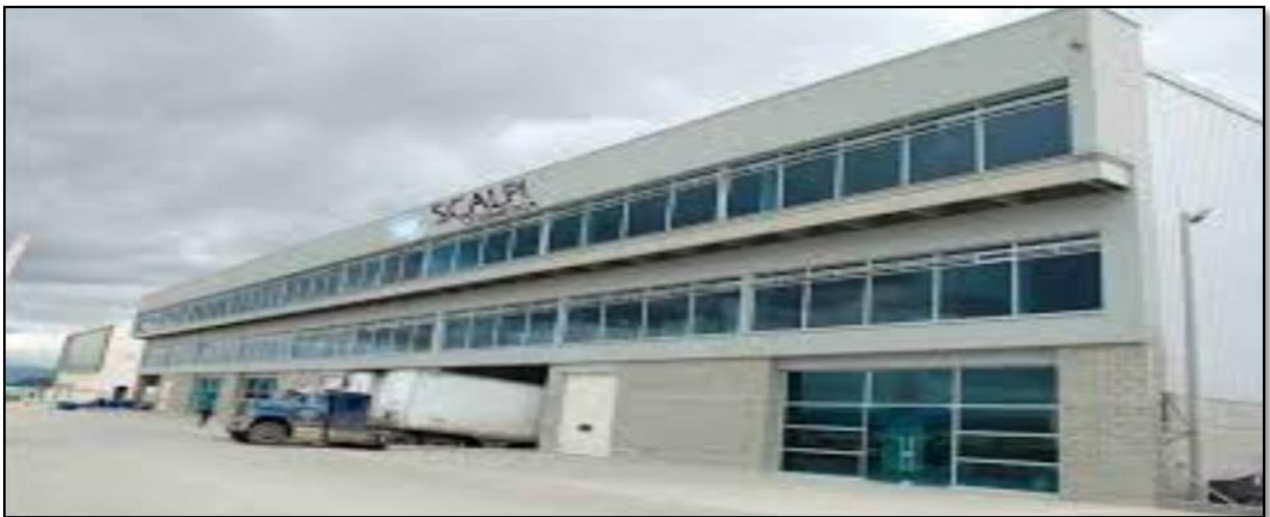
Figura 2 Infraestructura de Planta.
