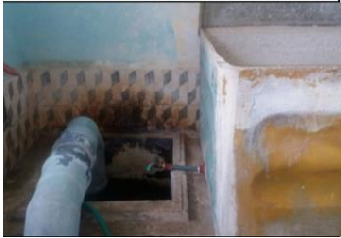
Fotografía 10. Caja de válvulas de control sin mantenimiento.
