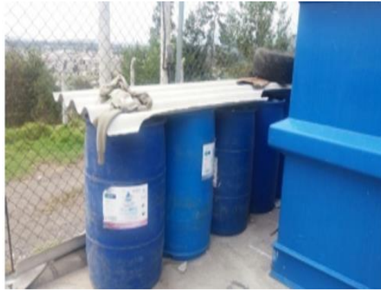
Fotografía 4. Falta de cubierta que garantice el correcto almacenamiento de sustancias químicas
