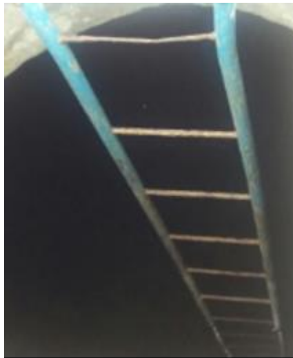
Fotografía 20. Falta de mantenimiento en los accesorios y herramientas que son parte del tanque de almacenamiento de agua de consumo humano.
