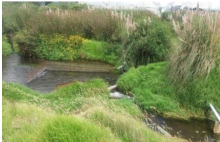
Fotografía 15. Captación de agua cruda. Sin señalética industrial.
