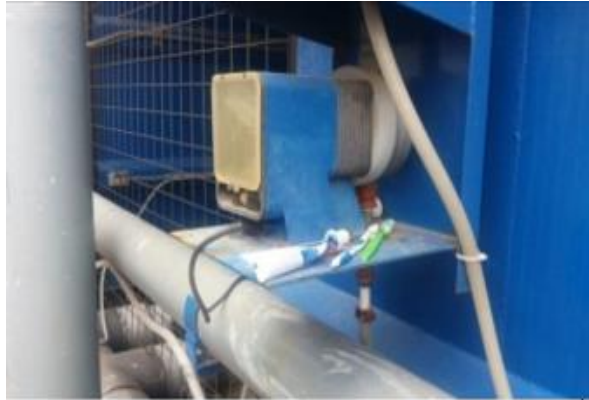
Fotografía 10. Caja de válvulas de control sin mantenimiento.
