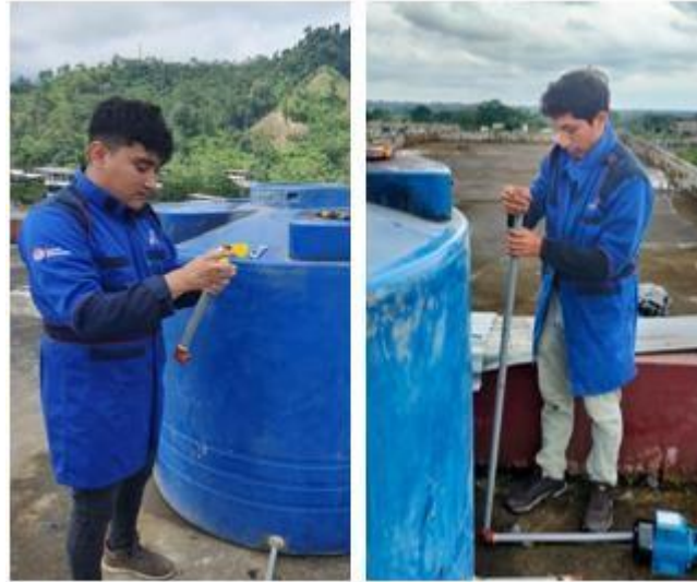
Figura 27. Cambio de tuberías
