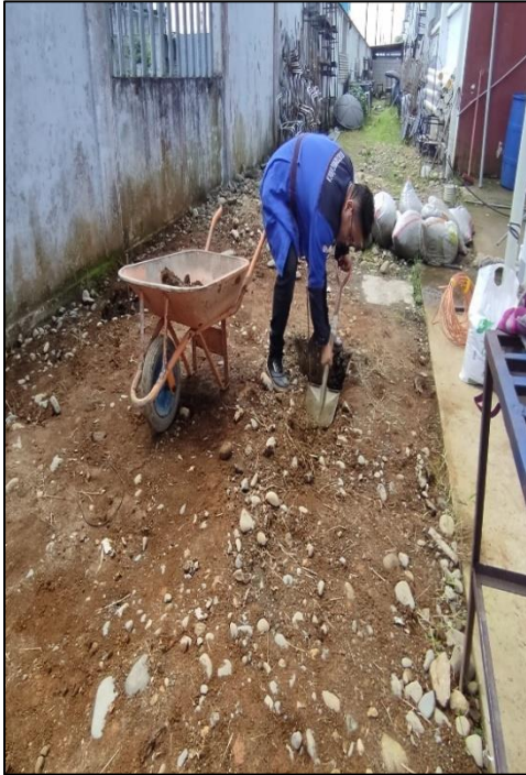
Figura 33. Desmontaje de maleza / Canal de aditivos
