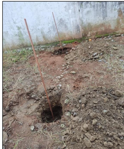
Figura 30. Colocación De Las Barras / Nivelación De Las Barras Copperweld
