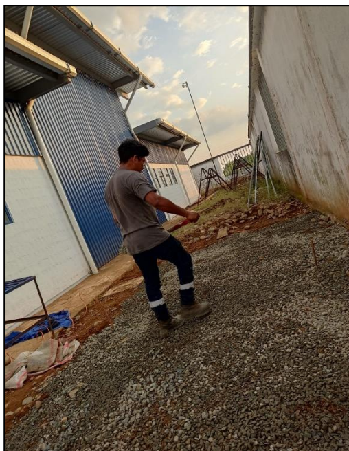
Figura 32. Nivelación de la grava / Tapado de aditivos
