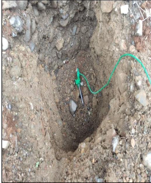
Figura 29. Preparación Del Terreno / Cavity Para Las Barras Copperweld.
