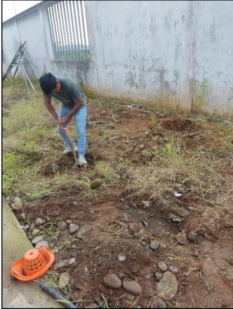
Figura 29. Preparación Del Terreno / Cavity Para Las Barras Copperweld.
