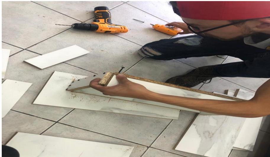
Figura 3.5. Ensamblado de moldes de melamina
