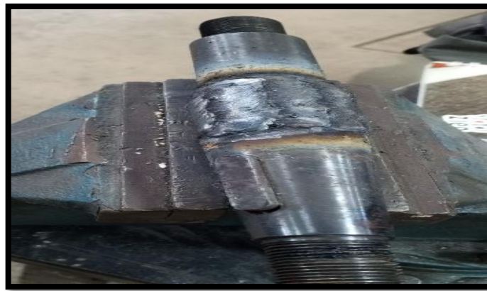
Figura 5.27. Eje rectificado con soldadura
