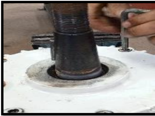
Figura 5.16. Desmontaje de generador con llave Allen
