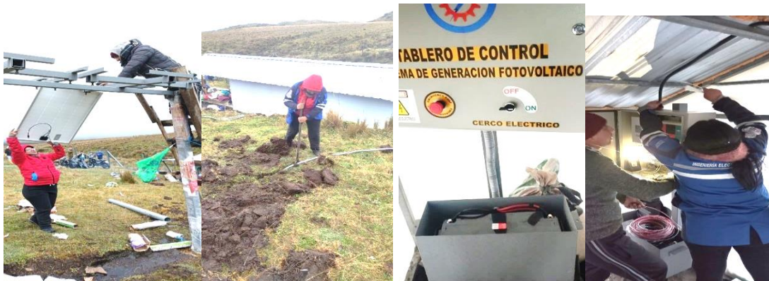
Figura 4.10. Colocación de paneles y cableado.
