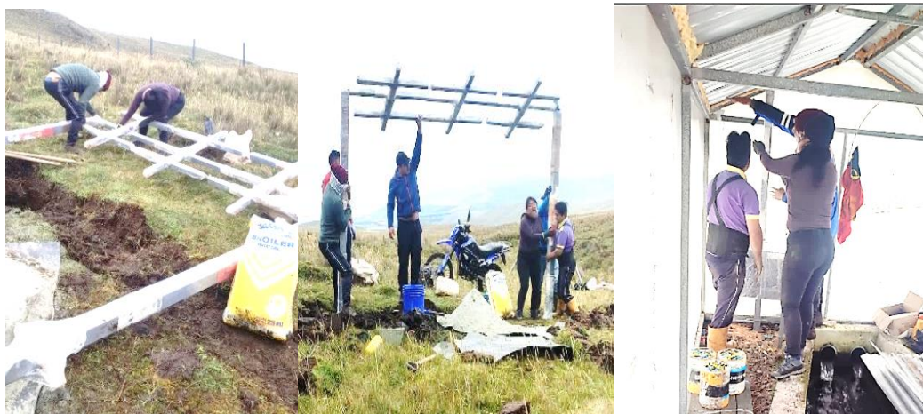
Figura 4.8. Ensamble y colocación de las estructuras en la zona de implementación.
