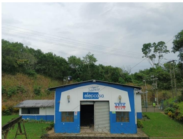
Figura 4.1. Mini Central Hidroeléctrica Catazacón.
