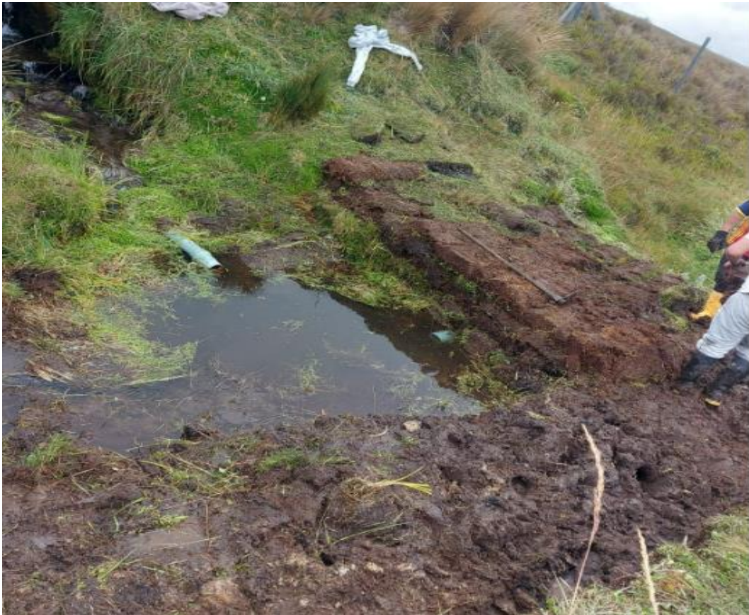
Inicio de la construcción de la represa (enchambado).
