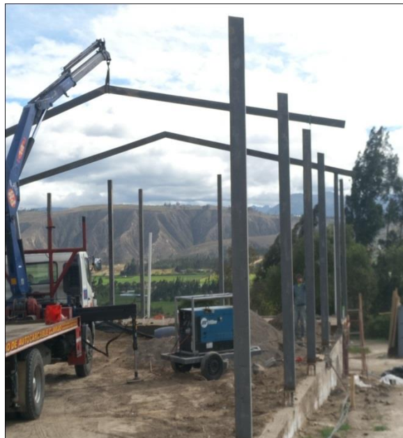
Figura 8: Estructura metálica complejo recreacional
