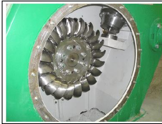
Figura 1.10 CARCASA DE LA TURBINA PELTON.
