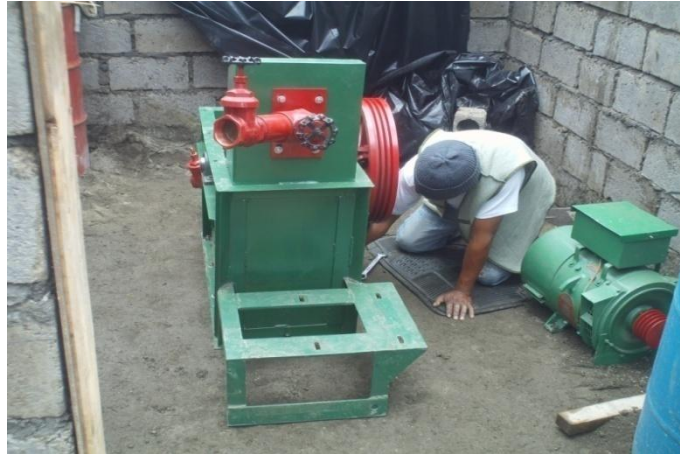
Figura: 3.37 SUJECCION DE EQUIPO Y COMPROVACIÓN DE NIVELADO DE BASE DE ACENTAMIENTO.
