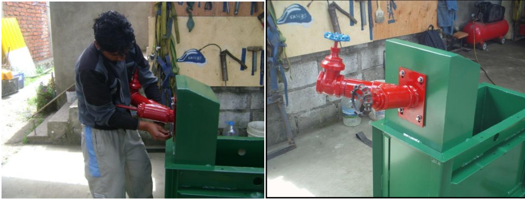
Figura: 3.33 INSTALACIÓN DE INYECTORES.
