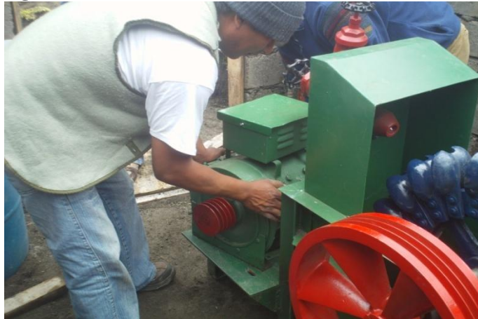
Figura: 3.40 MONTAJE Y FIJACION DE GENERADOR.
