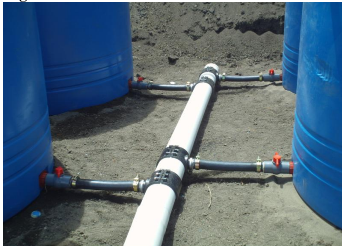
Figura: 3.39 FIJACION DE LA TUBERIA DE PRESIÓN.
