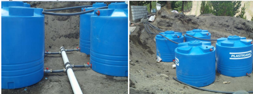
Figura 3.4 TANQUE DE PRESIÓN.
