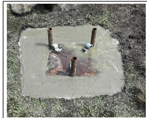
CONSTRUCCION DE LA BASE Y TEMPLADORES
