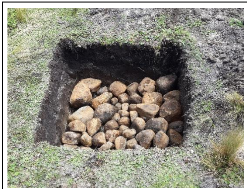
CONSTRUCCION DE LA BASE Y TEMPLADORES
