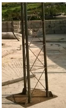
Gráfico N° 3. 8: SOLDADA DE LA PRIMERA PARTE EN LA PLANCHA DE ACERO
