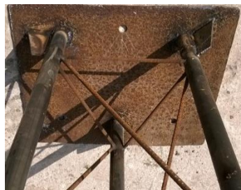
Gráfico N° 3. 7: PERFORACIONES EN LA PLANCHA DE ACERO
