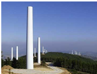
Grafico N° 1. 13: AEROGENERADOR TIPO TORRE TUBULAR
