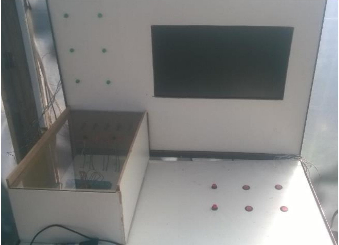
Figura 32. Tablero de control y monitoreo
