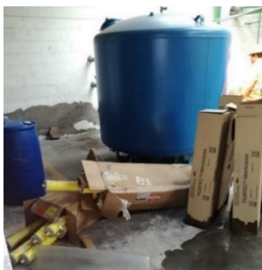
Figura 79: Membranas semipermeables a ser cambiadas en los sistemas de OI.
