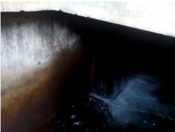
Figura 100: Proceso de decantación de agua subterránea.
