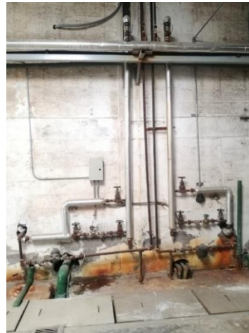
Figura 133: Purga de condensados de la tina N ° 23 de anodizado.
