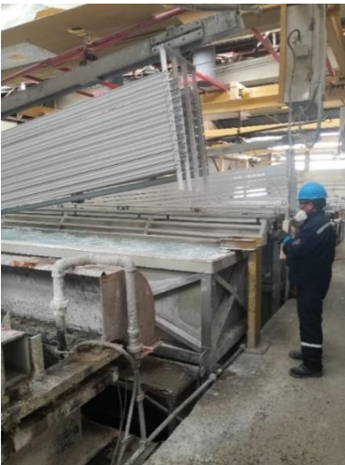
Figura 137: Baños del proceso de anodizado.
