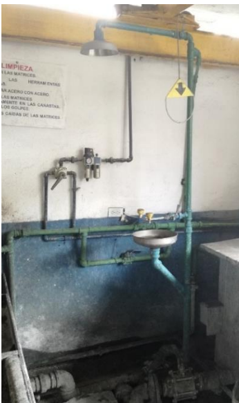
Figura 155: Ducha de emergencia en matricería.
