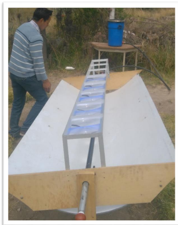
Instalación de un Recipiente Plástico de 60 Litros
