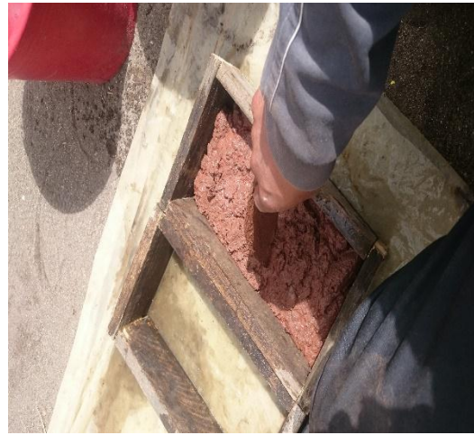
Anexo 9. Ubicar la mezcla en los moldes
