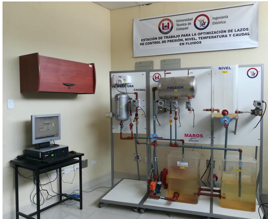
Figura 3.2. Construcción del banco de pruebas de lazo de control de temperatura (Fuente: José Baquero, autor)
