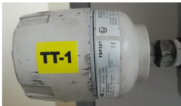
Figura 3.6. Transmisor indicador de temperatura (Fuente: José Baquero, autor)
