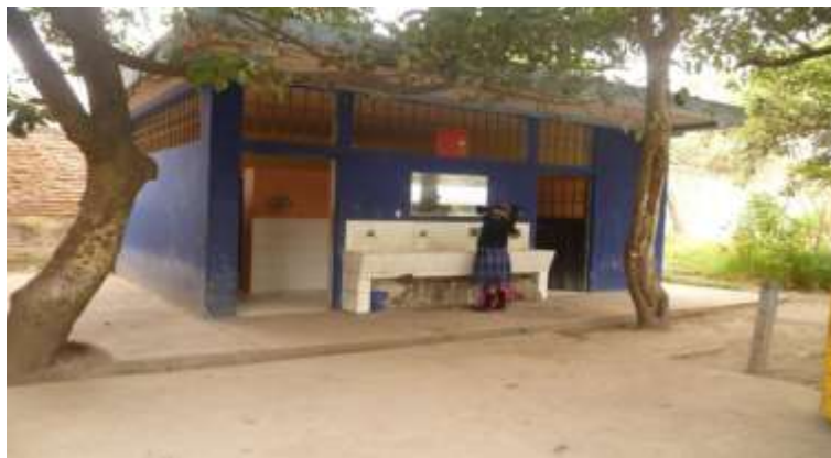
Imagen 19. Baño uno, junto al edificio administrativo del plantel
