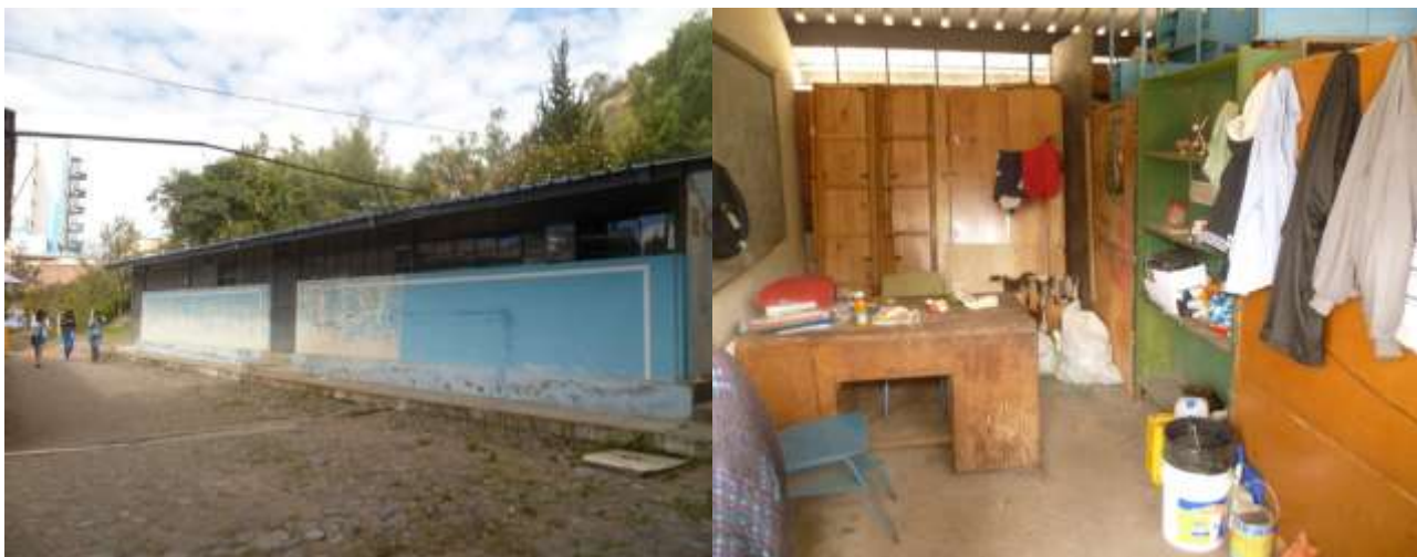
Imagen 26. Exterior e interior de la Bodega y equipos eléctricos
