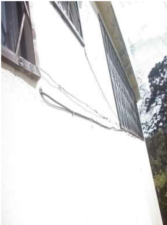
Imagen 49. Instalaciones eléctricas peligrosas en el plantel
