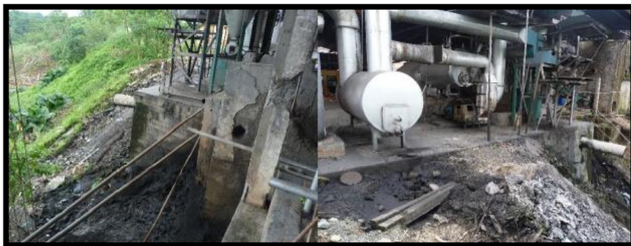
Gráfico 12. Descargas de Purgas provenientes del Caldero.
