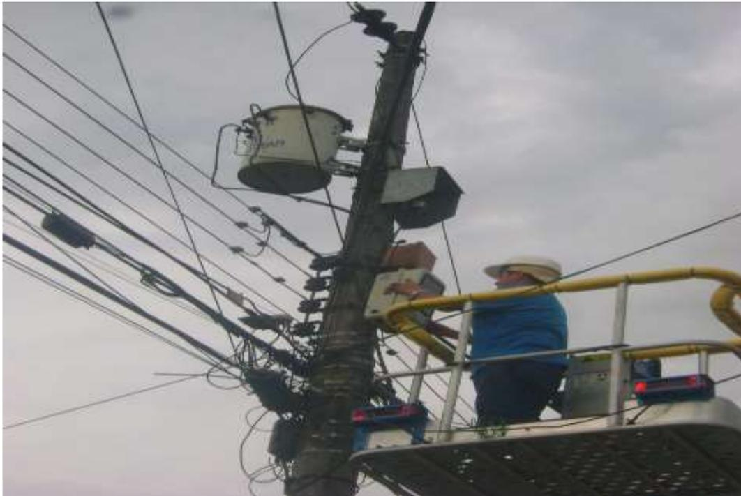
**Figura 3.9. Fotografía instalación del medidor eléctrico KV2c en el transformador eléctrico CT11825, Ing. Fabián Granja.**
