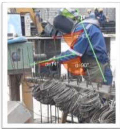
**Imagen N°10:** Operador de estribos (ángulos)
